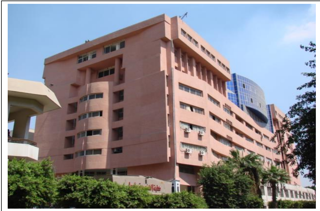
شكل (3-1): المبنى الفرعى لكلية الهندسة بشبرا.
