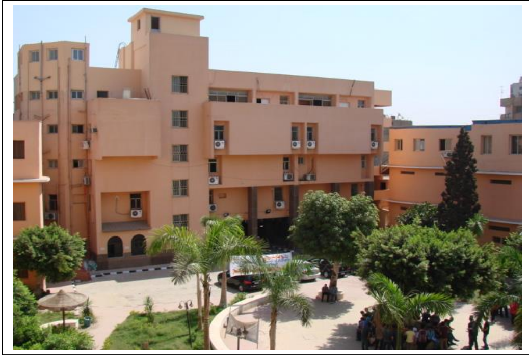
شكل (2-1): المبنى الرئيسي لكلية الهندسة بشبرا.
